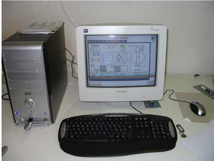
Fig.2 Postazione di controllo automatico dell'impianto SERMAP® con software dedicato
